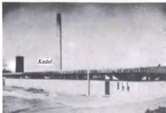
Kedel- og vaskeribygningen ved fuldførelsen i 1965. (Kilde: Puls).
